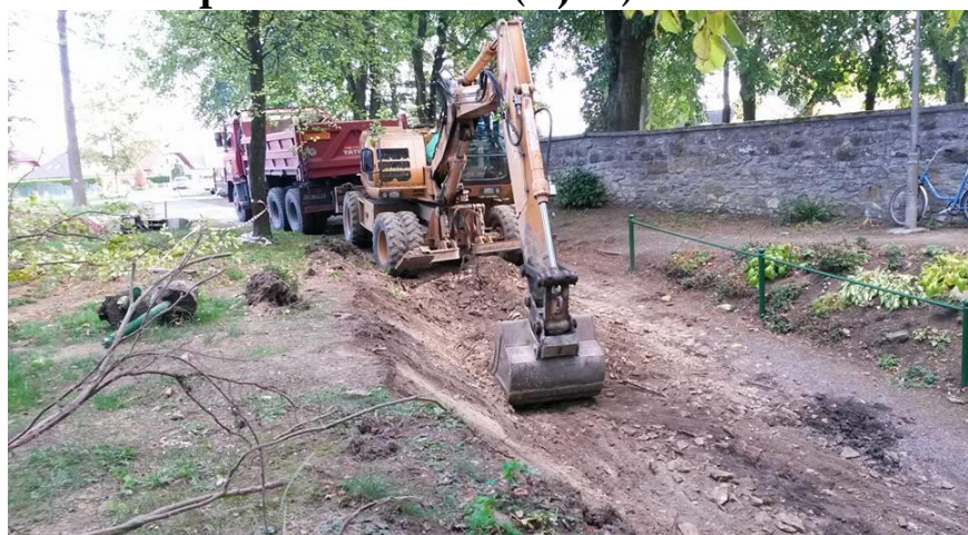
Zpevnění kopce ke hřbitovu (říjen)
