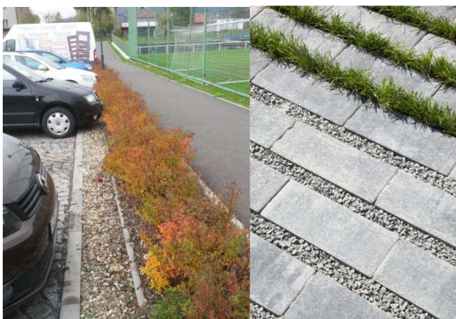
Použití zasakovací dlažby Best, odvodnění do okolních živých plotů
